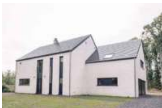
Une construction basée sur la PH34 pour nos clients à Trooz
