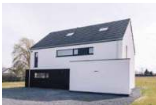
Une construction basée sur la PH34 pour nos clients à Ramillies
